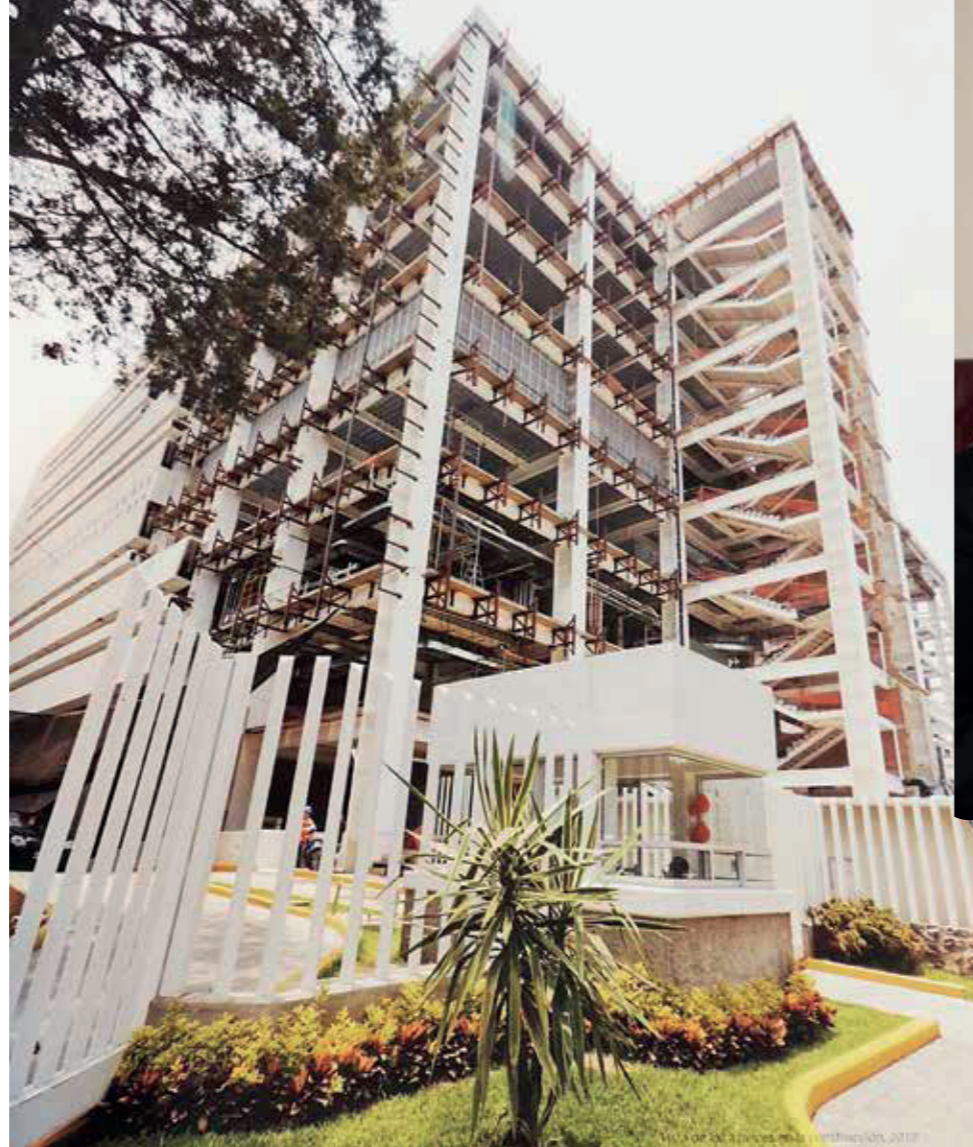
»» Durante la construcción de la Nueva Torre de Hospitalización del INCAN.
